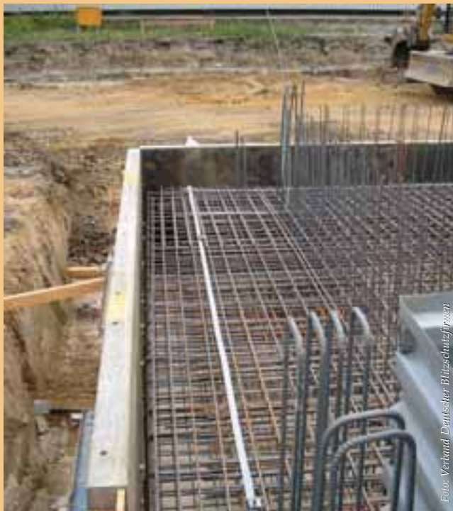
Fundamenterder im Bereich der Außenwände mit Bewehrungsanschluss.
