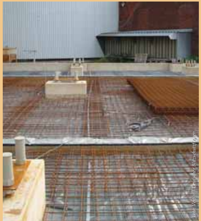
Querverbindung des Fundamenterders bei einer großen Bodenplatte.
