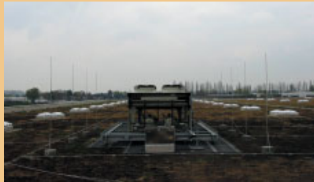
Fangstangen an einem großen Rückkühlgerät.
