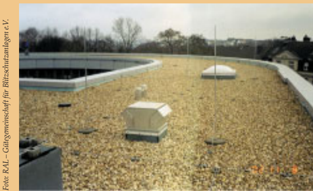
Fangstangen an mehreren Aufbauten.
