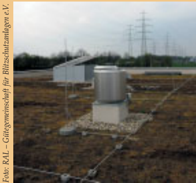
Fangstange an einem Lüfteraufbau.
