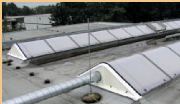
Fehlerhafte Anordnung, der Trennungsabstand zu leitfähigen Teilen der baulichen Anlage wurde nicht eingehalten.
